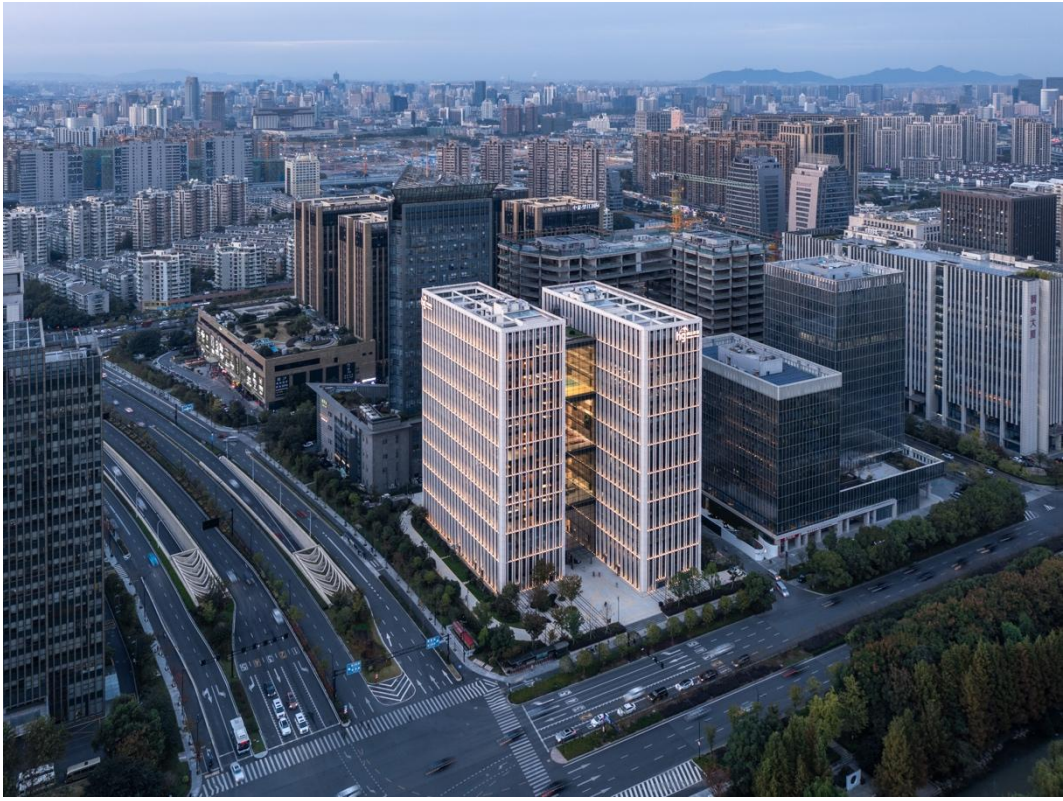
(杭州市上城区富春路 136 号—— 横店大厦外景)
